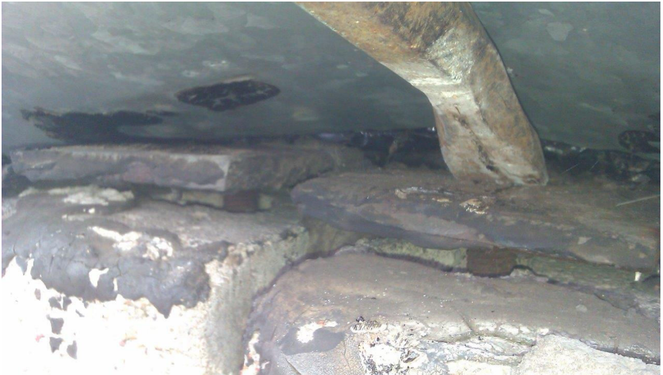
Mocowanie górne płyt 5/1+5/2 elewacji tylnej.
